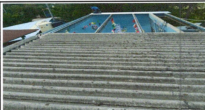
Foto 5: CAMBIO DE LAMINA DURALITA POR TROQUELADA
