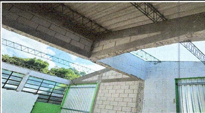
Foto 1: CAMBIO LAMINA PRIMER MODULO
