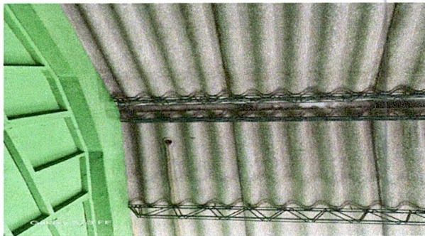
Foto 3: Cambio de estructura metalica por costanera
