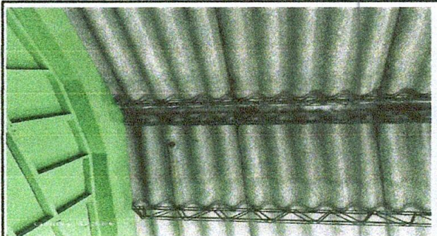
Foto 3: REFORZAMIENTO CON COSTANERAS
