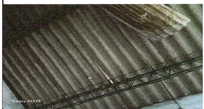
Foto 2: sustición de lámina duralita por lámina troquelada
