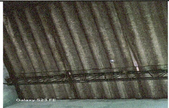
Foto 4: Cambio de estructura metalica por costanera
