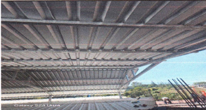
Foto 7: Seguimiento de largo y ancho de techo con estructura y lámina troquelada calibre 24 con medida de 3.50 de ancho y 22 metros de largo.
