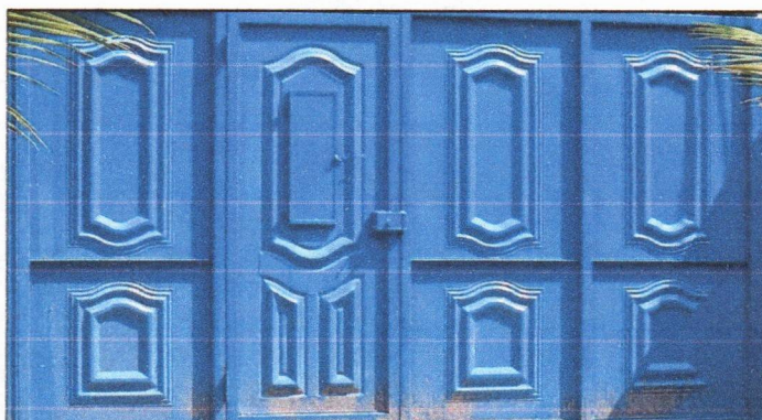
Foto 4: Sustitución de portón de malla por portón de metal
