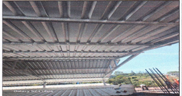
Foto 8: Sustitución de lámina por lámina troquelada calibre 24
