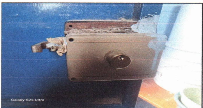
Foto 5: Sustitución de chapa por deterioro
