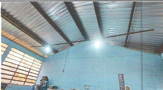
Foto 3: cambio de luces y sistema electrico
