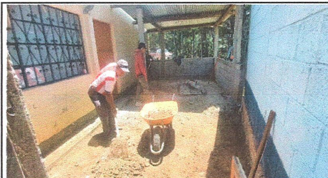
Foto 4: avanzando en la torta de concreto para la cocina
