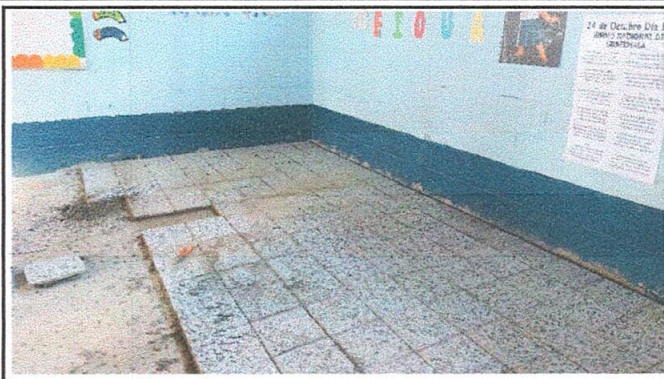
Foto 2: sustitucion de torta de cemento por piso de granito
