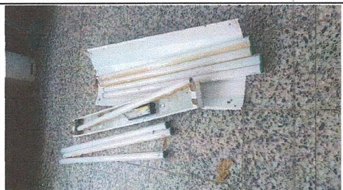
Foto 3: cambio de iluminacion en el sistema electrico
