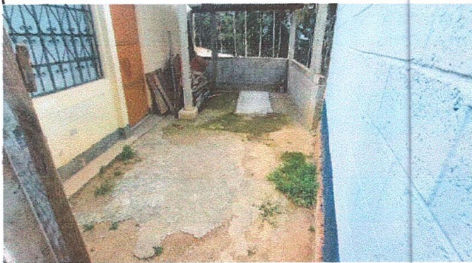
Foto 1: el piso es de tierra
