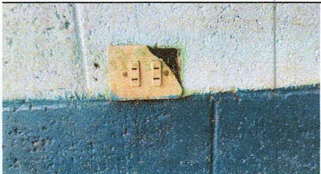
Foto 3: tomacorrientes y apagadores estan arruinados
