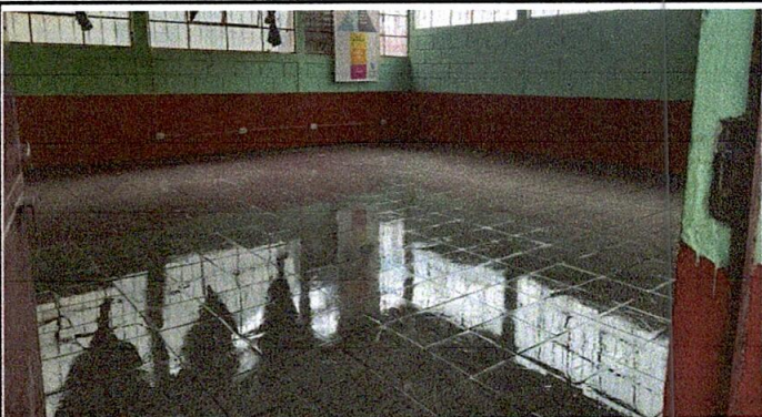
Foto 3: RENGLO PISO INSTALADO Y FINALIZADO
