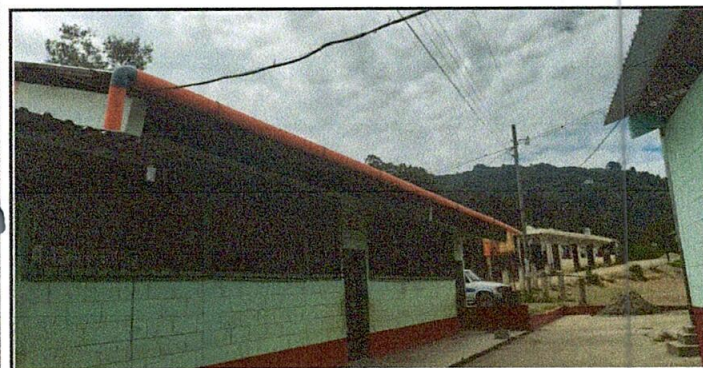
Foto 11: CANAL INSTALADO Y FINALIZADO CON TUBO PVC Y CODO
