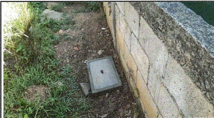
Foto 8: CAJA REGISTRADORA DE AGUA POTABLE INSTALADO Y FINALIZADO.
