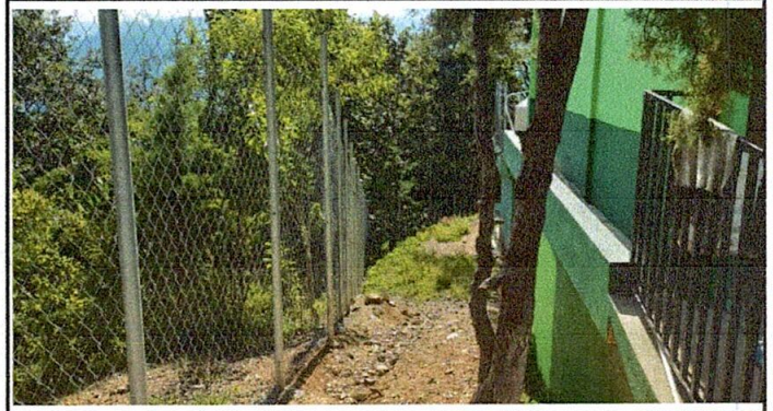
Foto 2: TUBOS Y MAYA GALVANIZADA INSTALADOS Y FINALIZADOS
