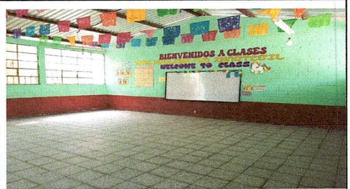
Foto 4: PISO DE GRANITO INSTALADO Y FINALIZADO
