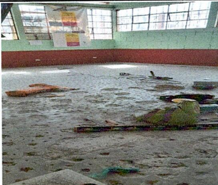
Foto 3: PREPARANDO NIVELACIÓN DEL ÁREA A INSTALAR PISO DE GRANITO
