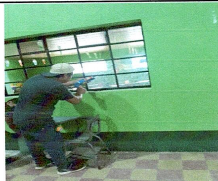
Foto 6: COLOCANDO VIDRIOS DE 180X99 CON CILICON.
