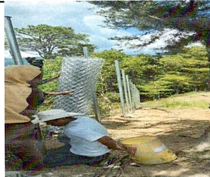
Foto 2: INSTALANDO MAYA GALVANIZADA HG
