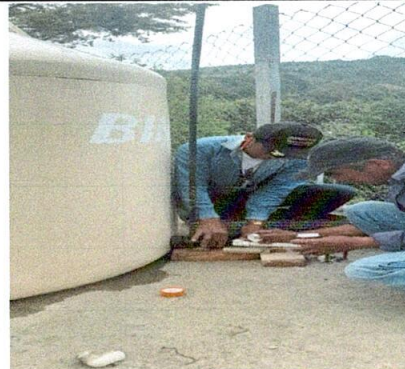
Foto 8: INSTALACIÓN DE ACCESORIOS
