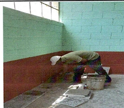
Foto 4: COLOCANDO PRIMERAS FILAS DE PISO DE GRANITO CON PEGACERÁMICA
