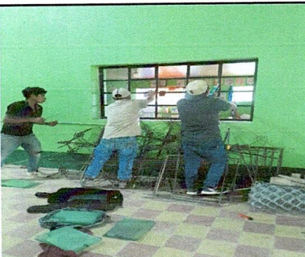
Foto 5: COLOCANDO VENTANAS CON ESTRUCTURA DE METAL Y VIDRIO
