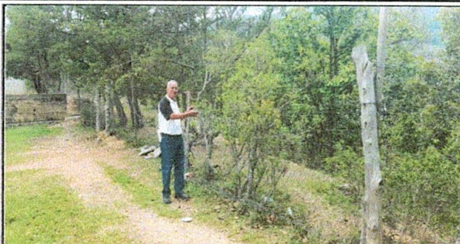
Foto 2: En su totalidad el circulado está en pésimas condiciones.
