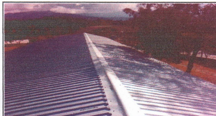
SUSTITUCION DE CAPOTE
