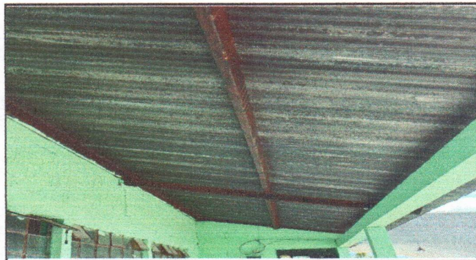
FOTO 4: SUSTITUCION DE SOPORTE DE METAL POR METAL
