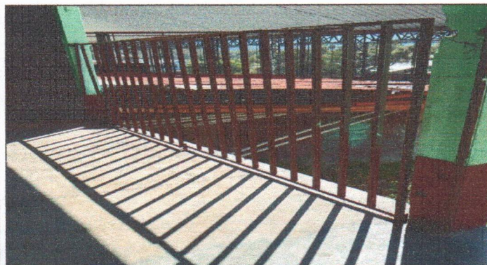
FOTO 3: SUSTITUCION DE BARANDA DE METAL
