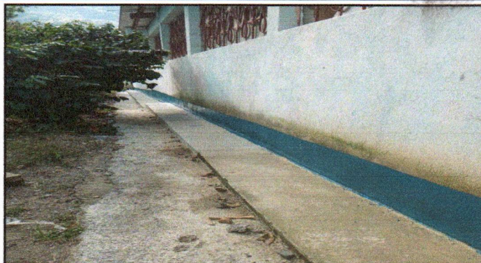
Foto 8: Sustitución de pintura de aceite
