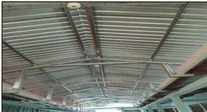
Foto 7: Mejoramiento de bajada de agua pluvial
