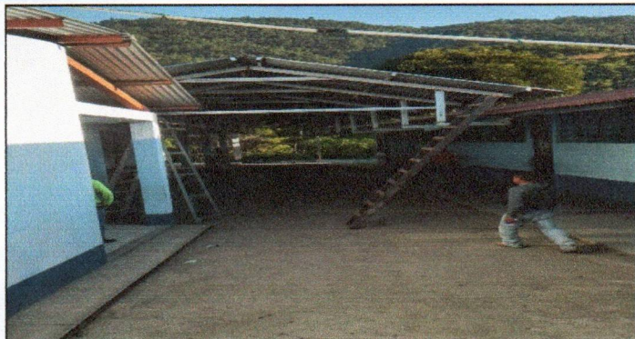
Foto1: Sustitución de soporte de madera, por metal
