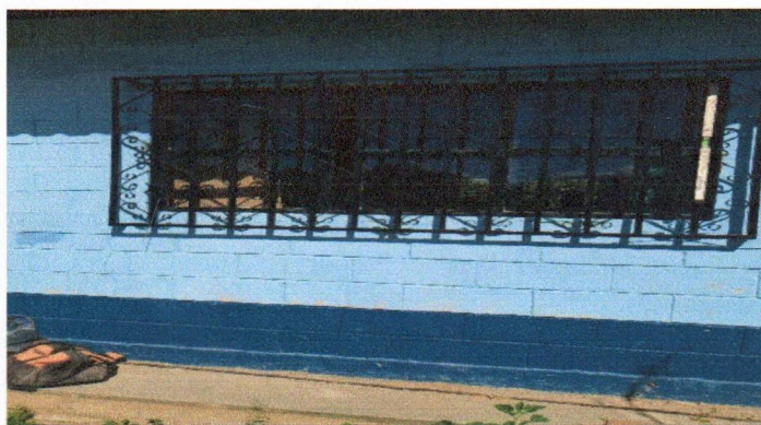
Foto 3: Sustitución de cada balcon
