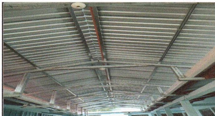
Foto 6: Sustitución del sistema eléctrico
