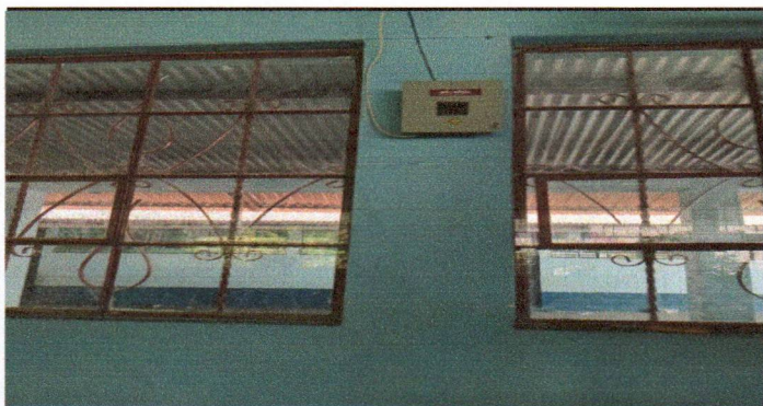
Foto 5: Sustitución del tablero de Flipon
