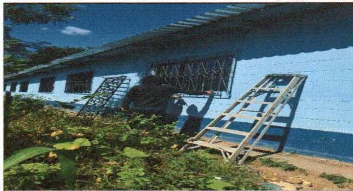
Foto 6: Sustitución de balcones
