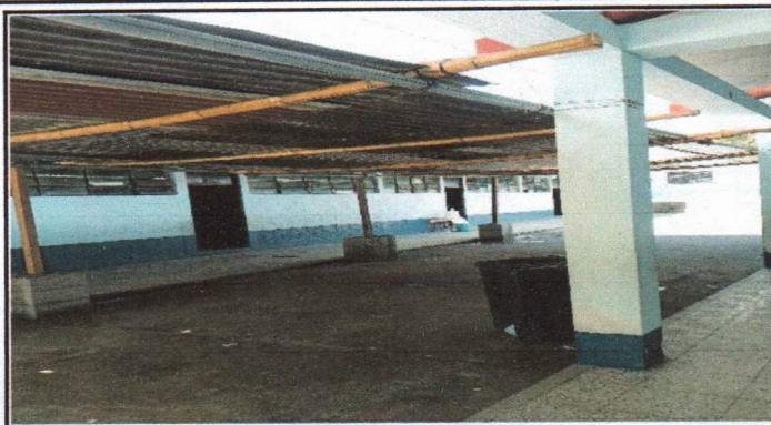
Foto 1: Sustitución de lámina, por lámina troquelada calibre 26 de 10 pies
