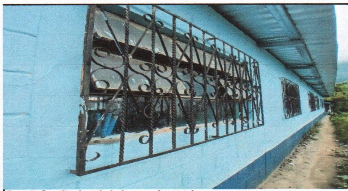
Foto 5: Sustitución de balcones de metal
