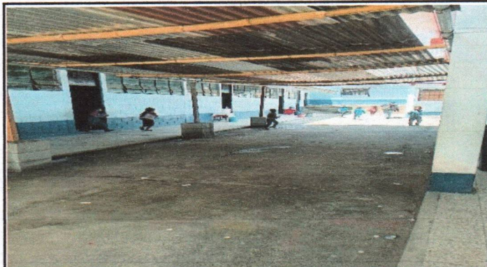
Foto 2: Sustitución de lámina, por lámina troquelada calibre 26 de 11 y 12 pies
