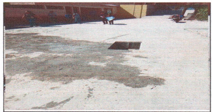
FOTO 6: SUSTITUCIÓN DE PISO DE CEMENTO DE CONCRETO
