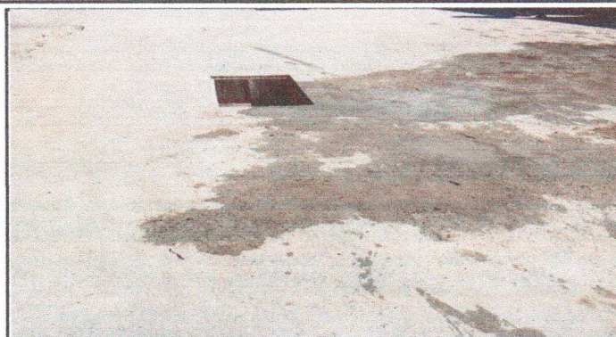
FOTO 7: SUSTITUCIÓN DE PISO DE CEMENTO DE CONCRETO
