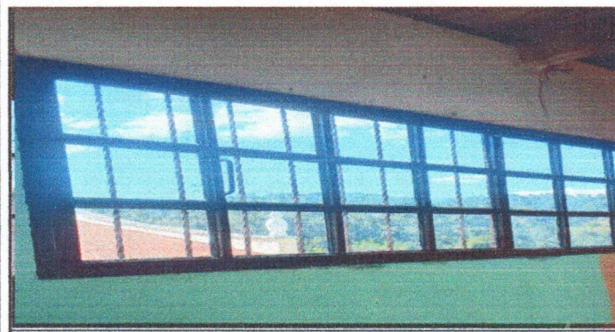
FOTO 5: SUSTITUCIÓN DE ESTRUCTURA DE METAL DE VENTANA
