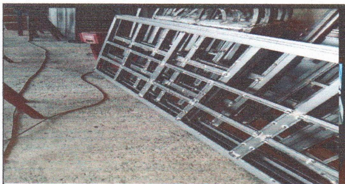
FOTO 5: SUSTITUCIÓN DE ESTRUCTURA DE METAL DE VENTANA
