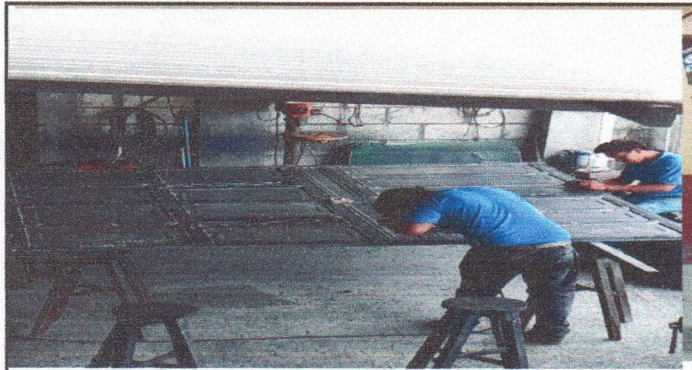
FOTO 3: SUSTITUCIÓN DE PORTON
