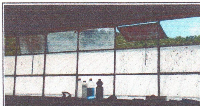
FOTO 4: SUSTITUCIÓN DE ESTRUCTURA DE METAL DE VENTANA
