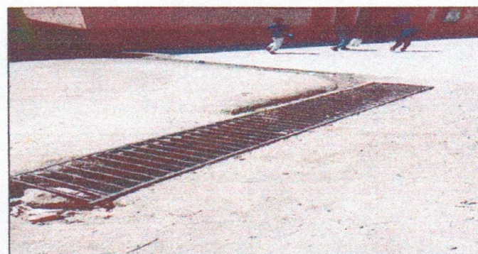
FOTO 6: SUSTITUCIÓN DE PISO DE CEMENTO DE CONCRETO
