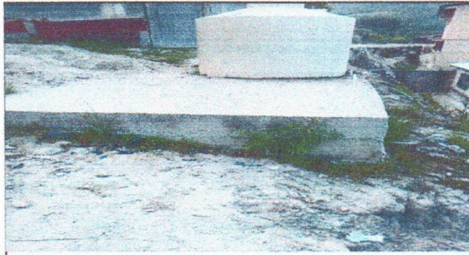
FOTO 8: SUSTITUCION DE DEPOSITO DE AGUA DE 2500 LITROS
