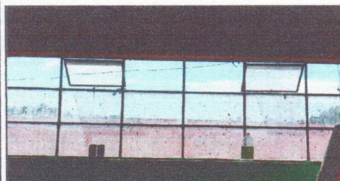
FOTO 5: SUSTITUCIÓN DE ESTRUCTURA DE METAL DE VENTANA
