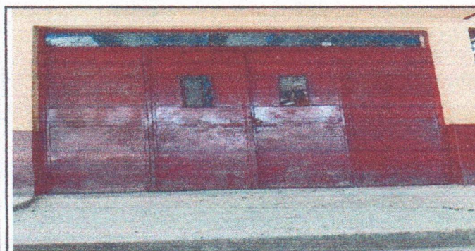
FOTO 3: SUSTITUCION DE PORTON
