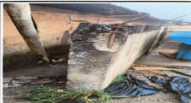
Muro perimetral de block
