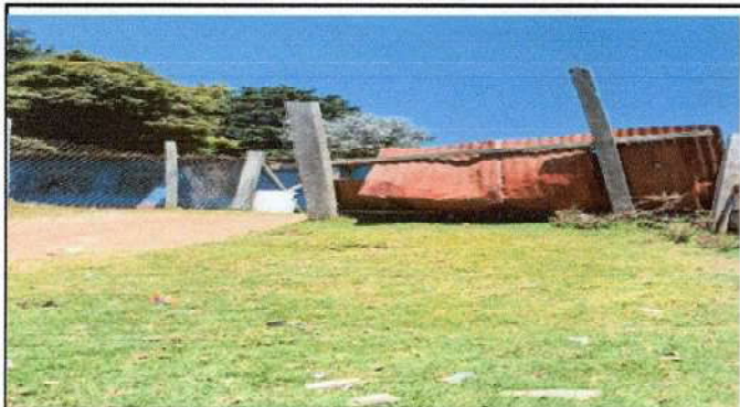
portón de metal de 5.90 mts. X 2.00 mts.
