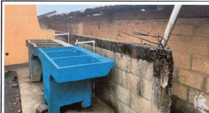
Muro perimetral de block
