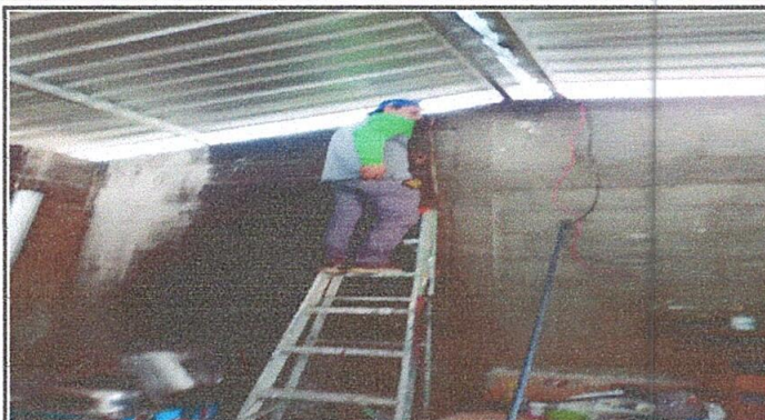
Foto1: ENTECHADO Y CANALES
