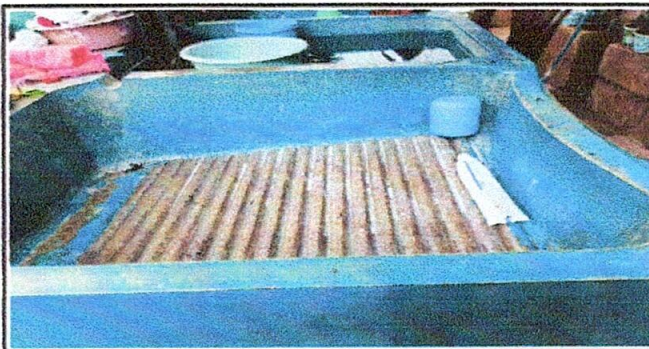
Foto 6: Sustitución de Pila
