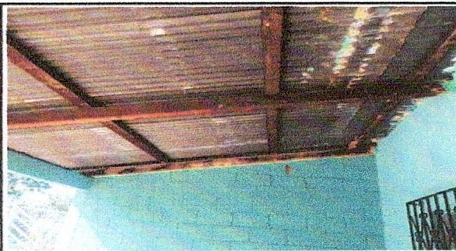
Foto 2: Entechado y Canales
