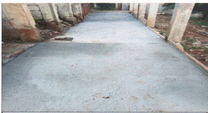
Foto 5: Sustrucción de piso de torta de concreto
