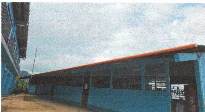
Foto 6: Sustrucción de canal de metal
