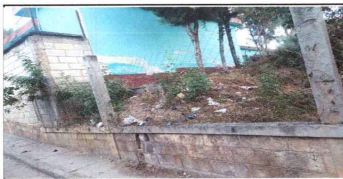
Foto 11: REPARACIÓN DE COLUMNAS INESTABLES
