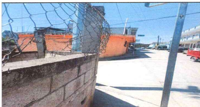
Foto 9: REPARACIÓN DE MURO PERIMETRAL EN MAL ESTADO
