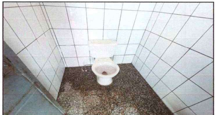
Foto 4: SUSTITUCIÓN PISO CERAMICO
