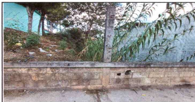
Foto 12: REPARACIÓN DE PARED EN MAL ESTADO.
