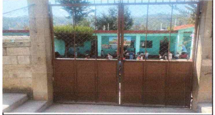
Foto2: SUSTITUCIÓN DE PORTON PRINCIPAL
