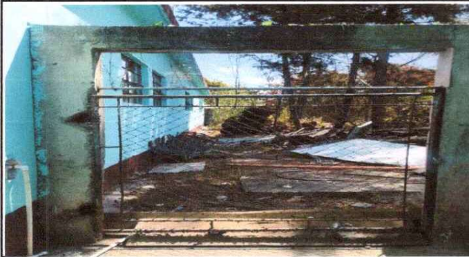
Foto1: SUSTITUCIÓN DE PUERTA
