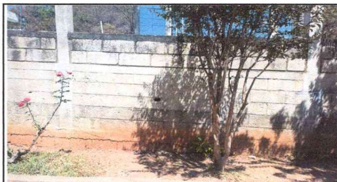
Foto 10: REPARACIÓN DE MURO DETERIORADO
