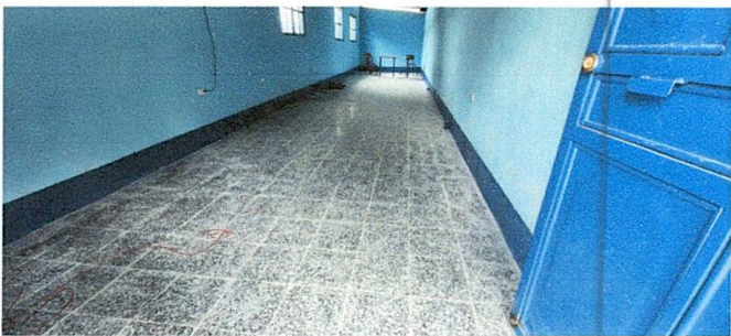
Foto 5: Piso de granito instalado dentro y fuera del laboratorio de computación.
