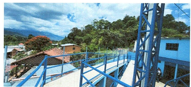
Foto 6: Malla en funcionamiento con soportes de tubo galvanizado.
