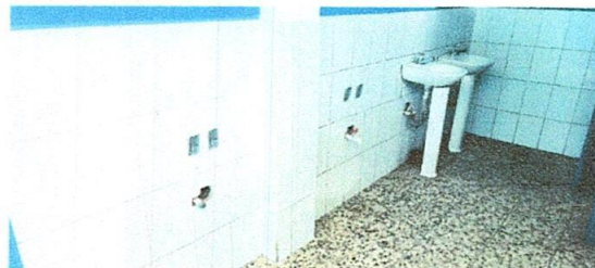
Foto 2: Mejoramiento de lavamanos
