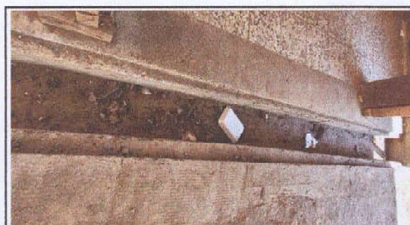
Reparacion de cuneta
