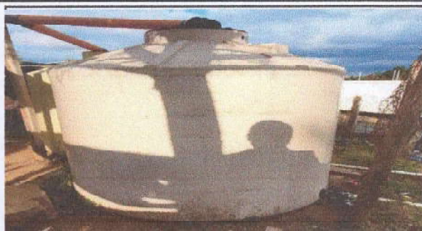
Sustitucion de sisterna prefabricada de 5000 litros
