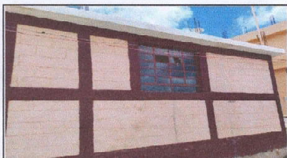
Sustitución de balcones
