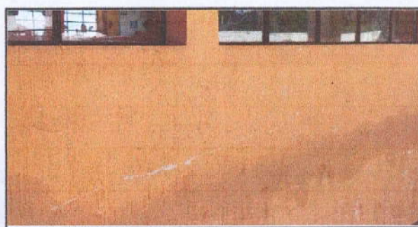
Pintura en exteriores e interiores
