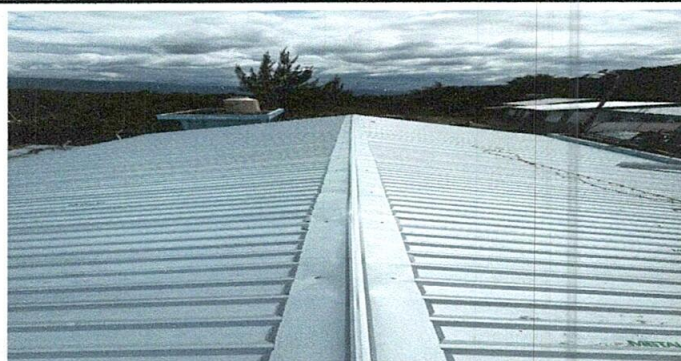
1: SUSTITUCIÓN DE LAMINA
