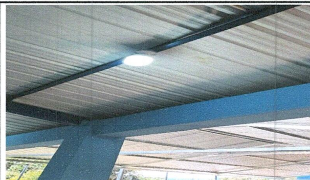
4: INSTALACIÓN DE LAMPARAS
