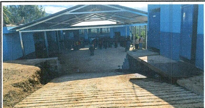
FOTO5: REPARACIÓN DE LOSA DE PATIO
