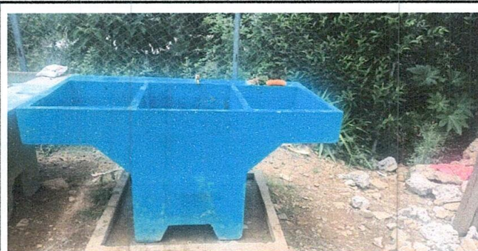
6: SUSTITUCIÓN DE PILA
