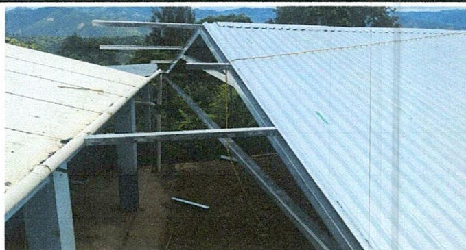
1: SUSTITUCIÓN DE LAMINA
