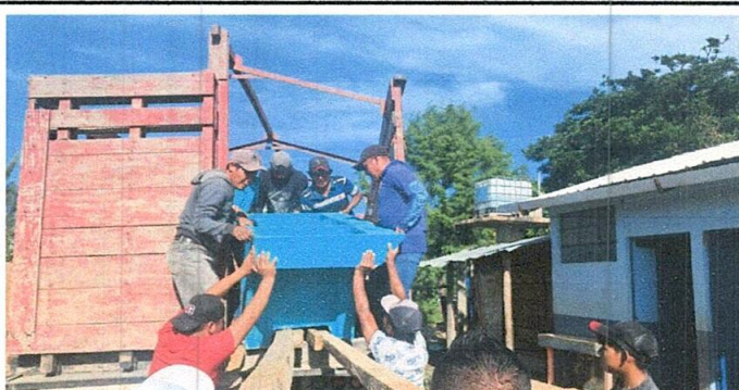
6: SUSTITUCIÓN DE PILA
