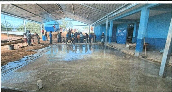
FOTO5: REPARACIÓN DE LOSA DE PATIO
