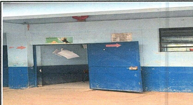
Foto 3: Sustitución de pintura en muros
