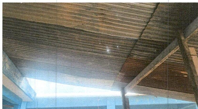
Foto 2: Sustitucion de estructura de madera por metal
