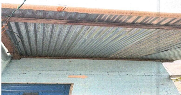
Foto 1: Sustitucion cubierta de lamina
