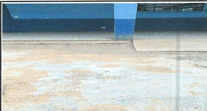
Foto 5: Reperación de losa de patio
