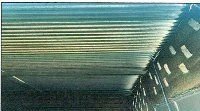
SUSTITUCIÓN DE LAMINA
