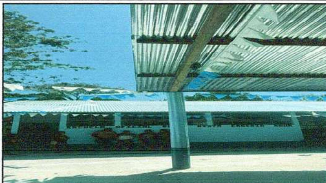
SUSTITUCIÓN DE ESTRUCTURA DE TECHO
