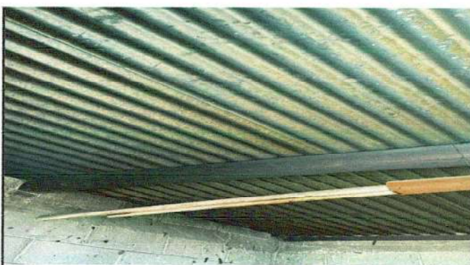
SUSTITUCIÓN DE ESTRUCTURA DE TECHO
