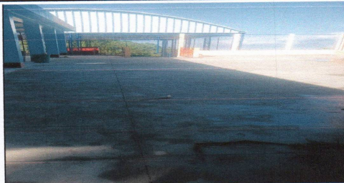
SUSTITUCIÓN DE LOZA DE PATIO
