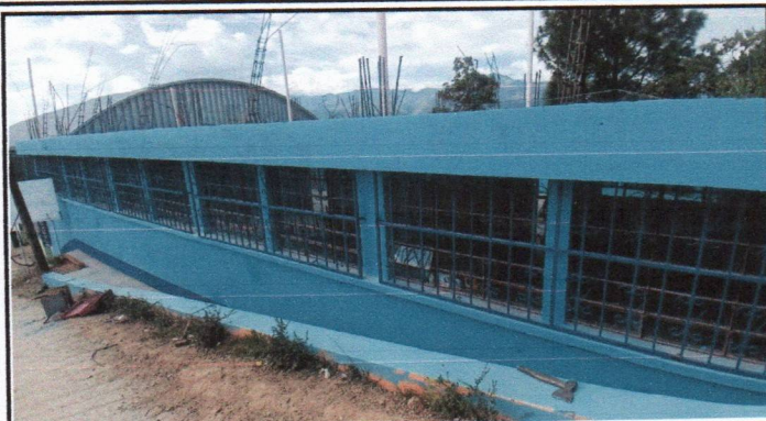
SUSTITUCIÓN DE BALCONES DE METAL
