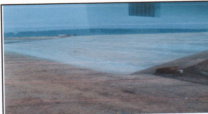
REPARACION DE CUNETA DE CONCRETO
