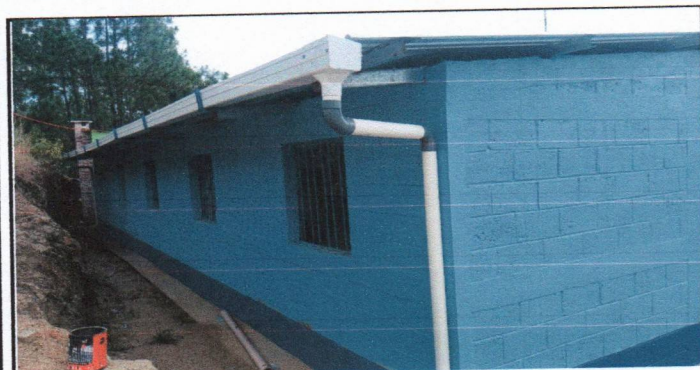
SUSTITUCIONES DE CANALES Y BAJADAS DE AGUA
