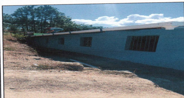
SUSTITUCION DE CANALES Y BAJADAS DE AGUA
