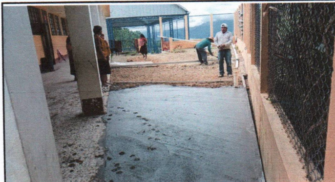
SUSTITUCIÓN DE LOZA DE PATIO
