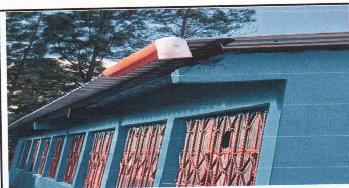
SUSTITUCIONES DE CANALES Y BAJADAS DE AGUA
