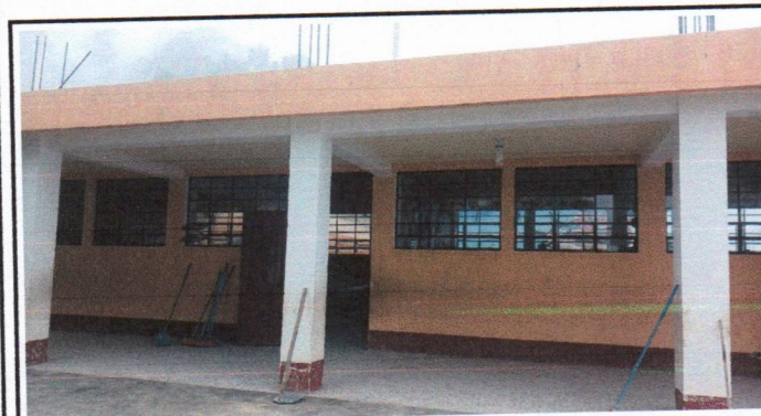
PINTURA EN MUROS INTERIORES Y EXTERIORES
