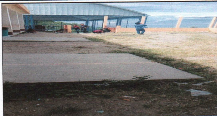
SUSTITUCIÓN DE LOZA DE PATIO
