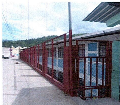
Foto 4: Malla o circulación finalizada
