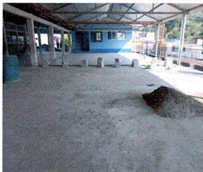
Foto 1: Piso en proceso
