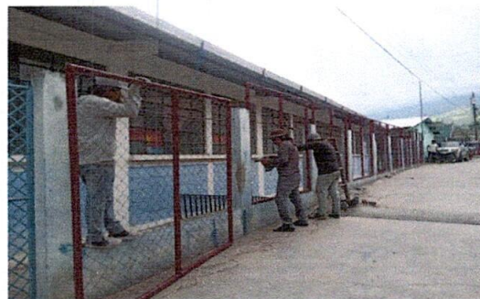
Foto 4: Malla o circulación en proceso
