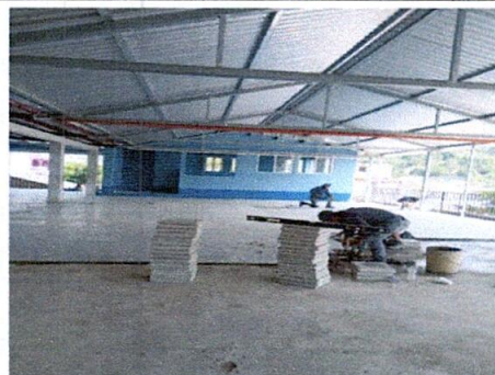
Foto 2: Piso en proceso
