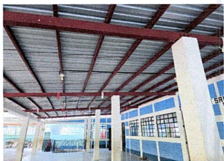
Foto 5: Focos e instalación en proceso
