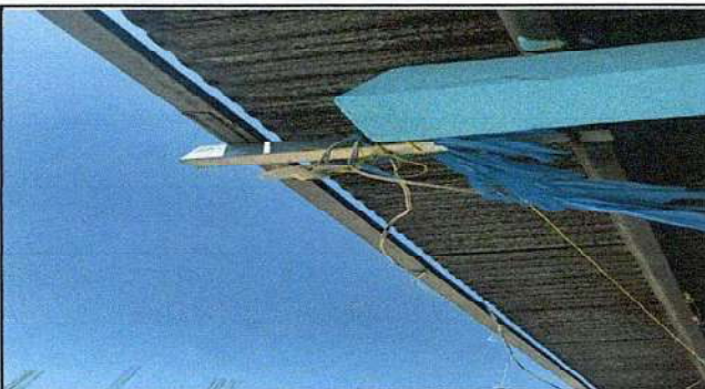
SUSTITUCIÓN DE LAMINA POR LAMINA TROQUELADA
