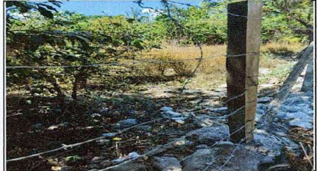
REPARACIÓN DE MURO PERIMETRAL
