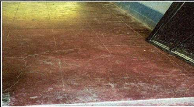
SUSTITUCIÓN DE PISO DE TORTA POR PISO GRANITO
