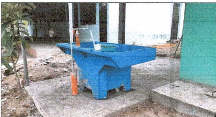
Foto 5: Sustitucion de pila
