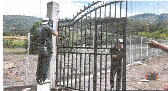
Foto 6: Sustitucion de portón
