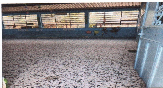
Foto 5: Sustrucción de torta de cemento por piso de granito
