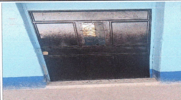
Foto 1: Sustrucción de puerta
