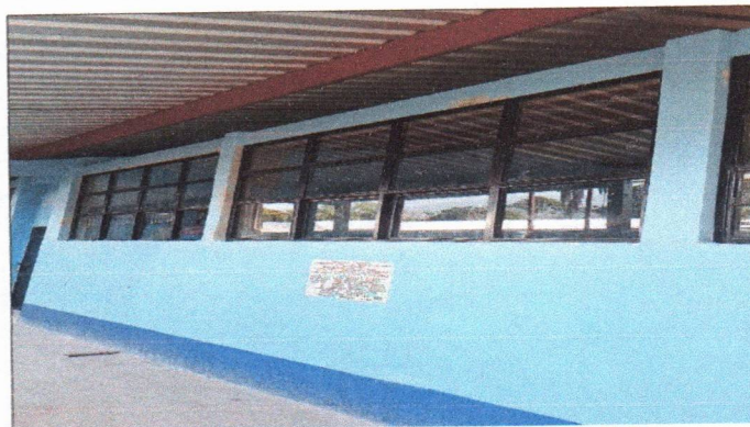
Foto 4: Sustrucción de ventanas de metal por ventanas de PVC.
