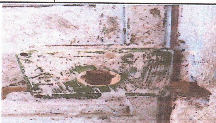
Foto 2: Sustitución de chapa
