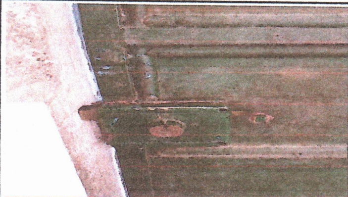
Foto 1: Sustitución de puerta
