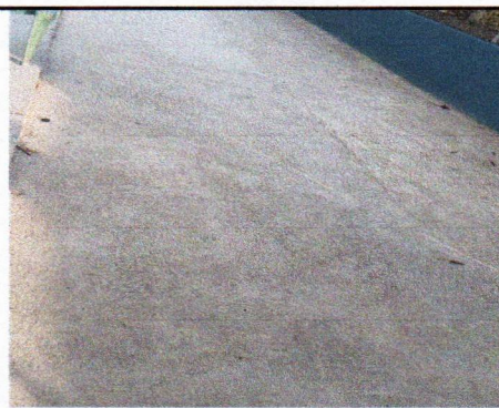
Foto 6: LOSA DE PATIO
