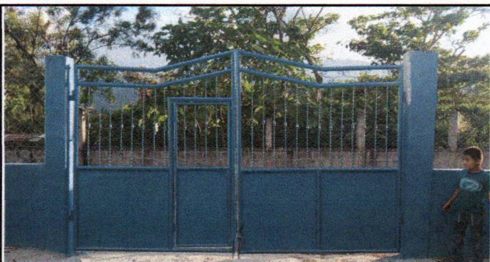
Foto 5: MANTENIMIENTO A PORTONES
