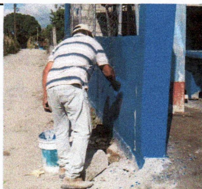
Foto 4: PINTURA EN MUROS EXTERIORES E INTERIORES
