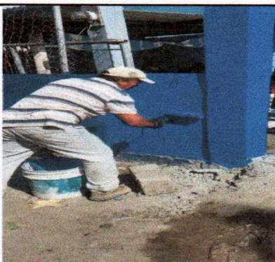
Foto 3: PINTURA EN MUROS EXTERIORES E INTERIORES
