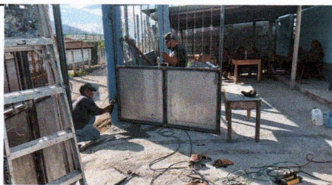
Foto 5: MANTENIMIENTO A PORTONES
