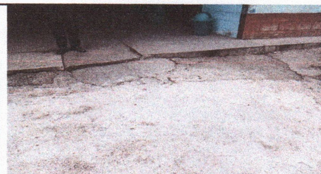
Foto 6: Reparación de losa de patio
