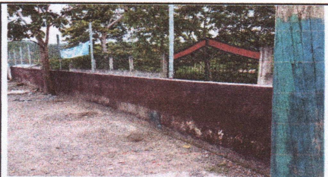
Foto 4: Reparación de malla galvanizada y tubo HG
