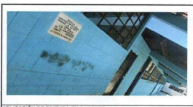
APLICACIÓN DE PINTURA EN PAREDES
