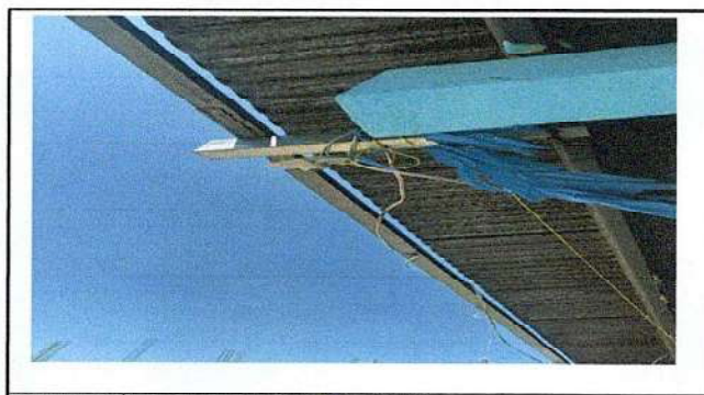
SUSTITUCIÓN DE PLAFONERAS Y CABLEADO
