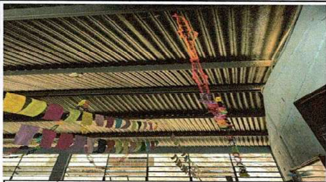
SUSTITUCIÓN DE LAMINA POR LAMINA TROQUELADA
