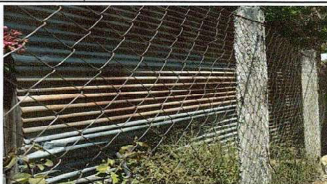
REPARACIÓN DE MURO PERIMETRAL
