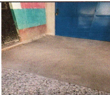
Foto 5: Sustitución de piso torta de concreto.
