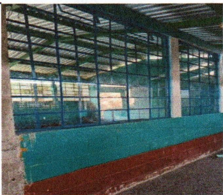
Foto 1: Mantenimiento de ventanas y sustitución de vidrios.
