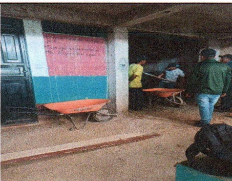
Foto 5: Sustitución de piso torta de concreto.
