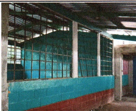
Foto1: Mantenimiento de ventanas y sustitución de vidrios.
