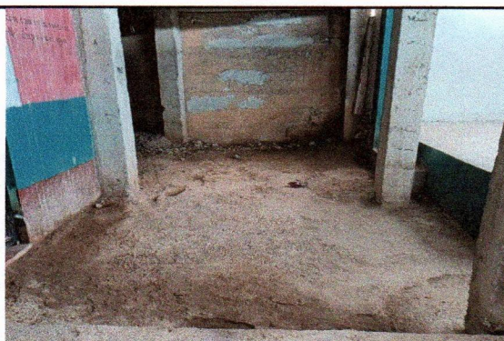
Foto 5: Sustitución de piso torta de concreto.
