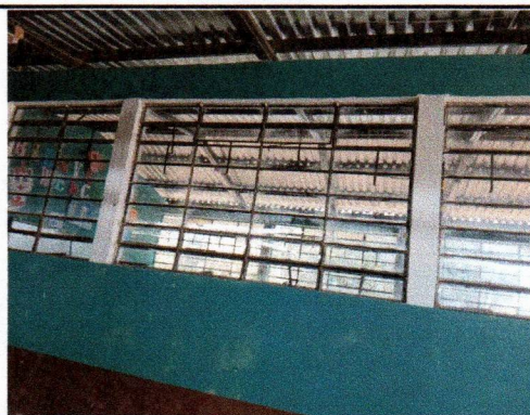
Foto 2: Mejoramiento de balcones frente a 3 aulas y bodega.
