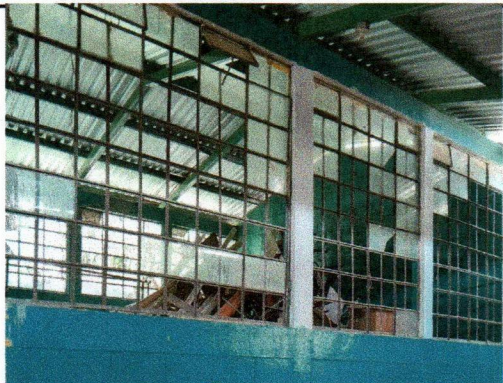
Foto 1: Mantenimiento de ventanas y sustitución de vidrios.
