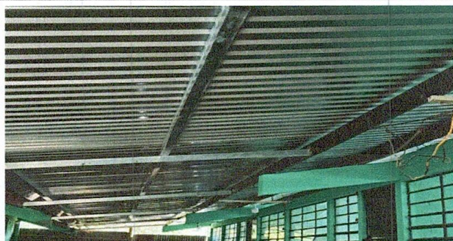
Foto 2: CAMBIO DE LAMINA TROQUELADA
