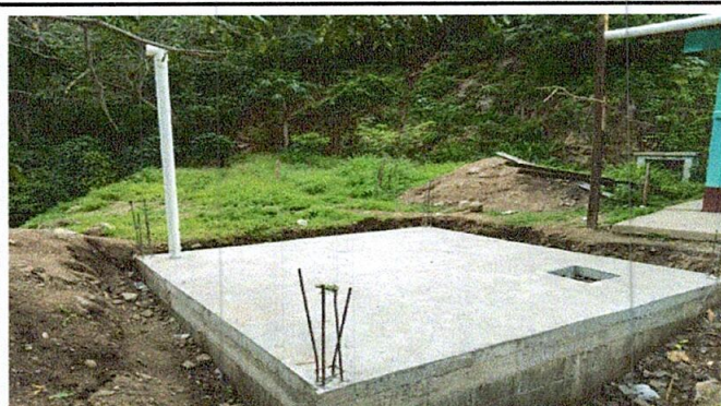
Foto 4: TERMINACION DE FOSA SEPTICA
