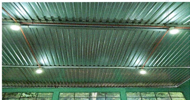
Foto1: CAMBIO CABLEADO ELECTRICO
