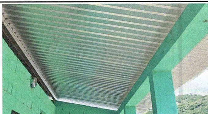
Foto 3: CAMBIO DE LAMINA
