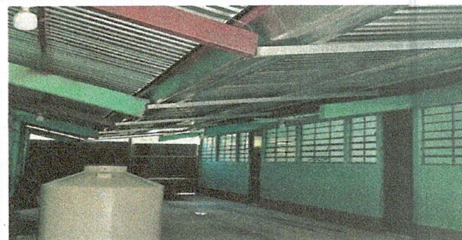
Foto 5: CAMBIO DE ESTRUCTURA DE MADERA POR METAL
