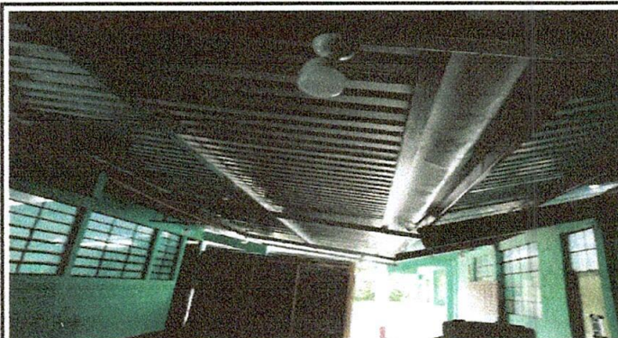
Foto 1: CAMBIO LAMINA PRIMER MODULO
