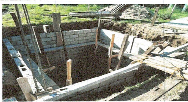
Foto 4: CONSTRUCCION DE LA FOSA SEPTICA CON BLOCK
