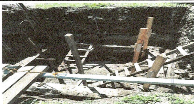
Foto 3: AMPLIACION DE LA FOSA SEPTICA
